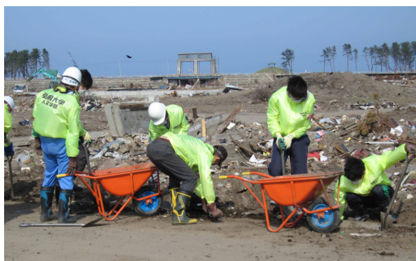
側溝に溜った泥やガレキをかき出す作業
