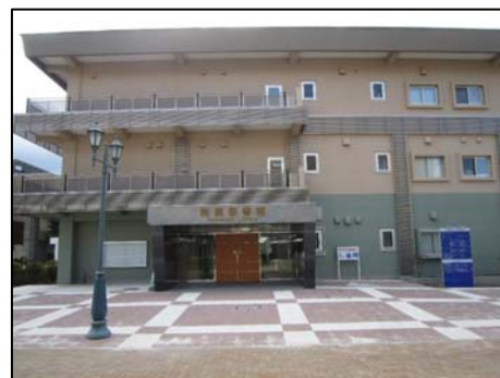
安全性への配慮とバリアフリー化した 1 階利用者入口
