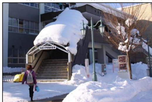
危険性のあった2階への利用者入口
